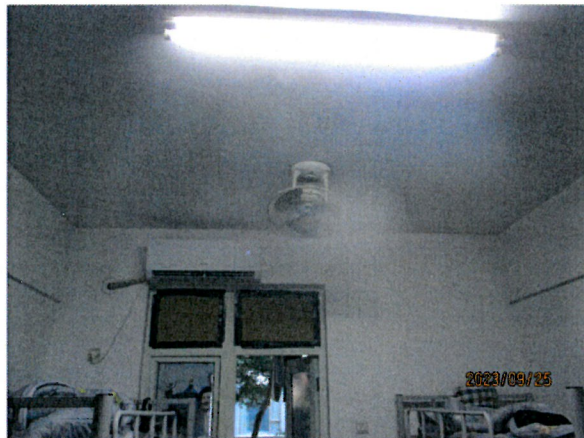
照片二：房屋内景现状
