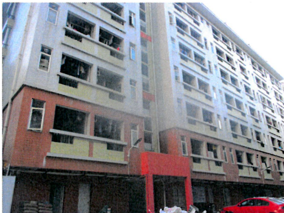
照片一：房屋外观现状
