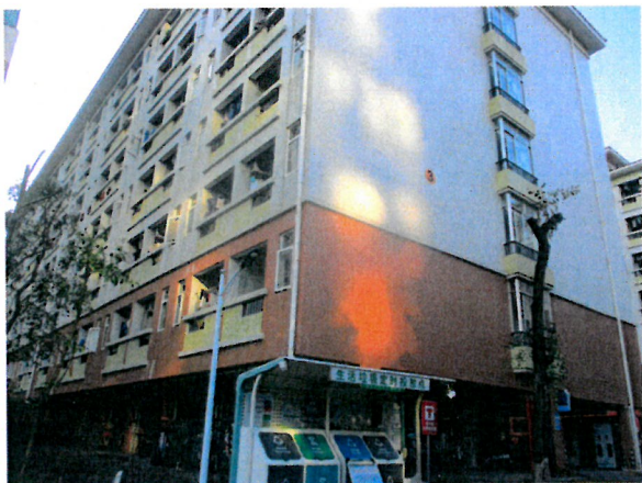
照片一：房屋外观现状
